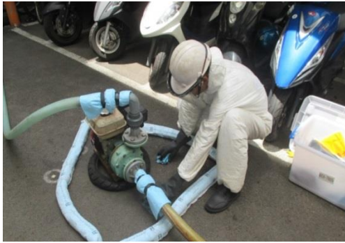
进行化学槽车卸料检点
